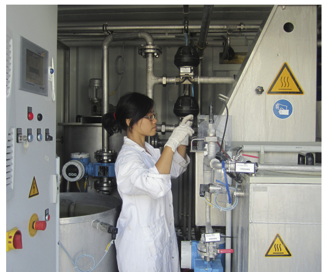
Betrieb einer Versuchsanlage mit Membrantechnik zur Behandlung von Prozessabwässern eines Industriebetriebes in Vietnam
